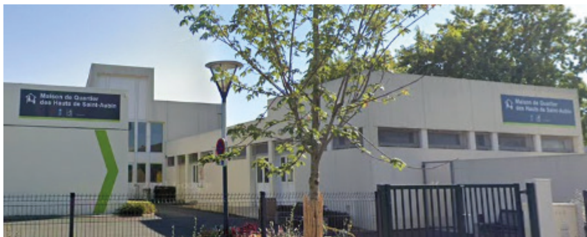
La maison de quartier des Hauts de Saint Aubin
